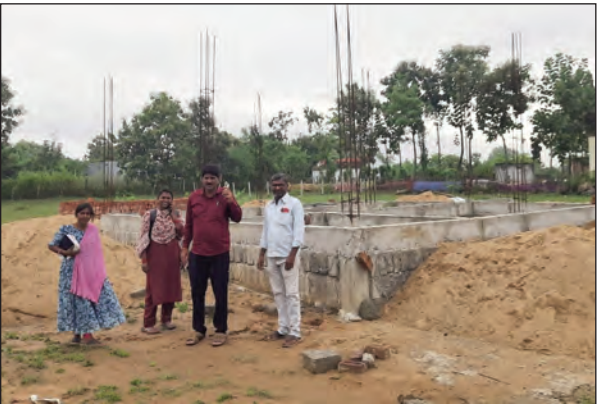
ఇందిరమ్మ ఇంటి నిర్మాణాన్ని పరిశీలిస్తున్న మండల పంచాయతీ అధికారి
